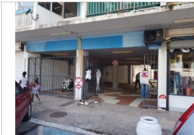
Vue du site - Auteur : Cerema
