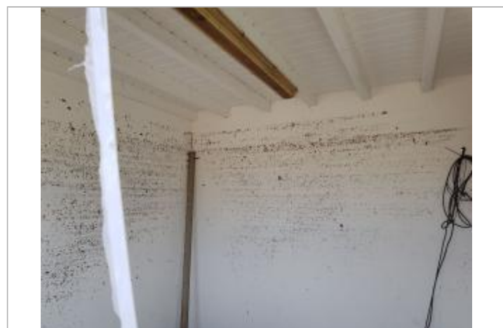
Vue de la PHE - Auteur : Cerema
