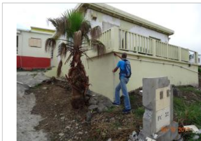
Vue de la PHE - Auteur : Cerema
