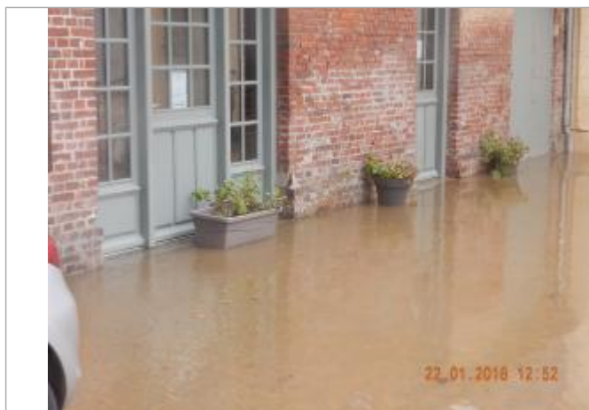
Niveau d'eau atteint le pas de porte de la baie vitrée (photo SPC SACN)
