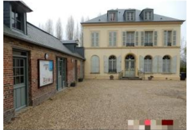
Porte vitrée de la dépendance ouest du Presbytère (photo SPC SACN)
