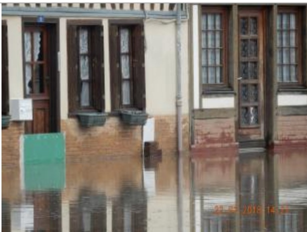
Niveau d'eau au bas du batard d'eau mis sur le pas de porte (photo SPC SACN)
