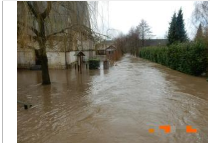
Escalier est de l'église de Bonneville-la-Louvet (Source: SPC SACN)
