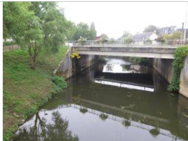
Echelle limnimétrique de la Vilaine à Chateaubourg
