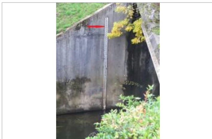
Echelle limnimétrique de la station de Chateaubourg.
