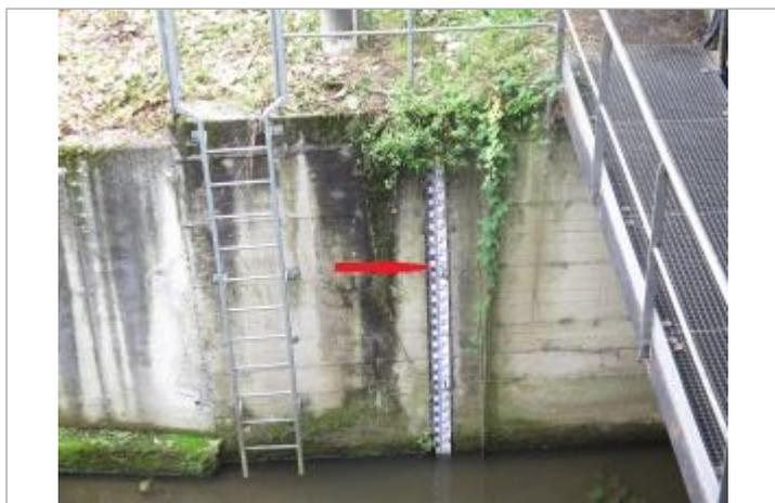
Echelle limnimétrique de la station de Vitré Bas Pont
