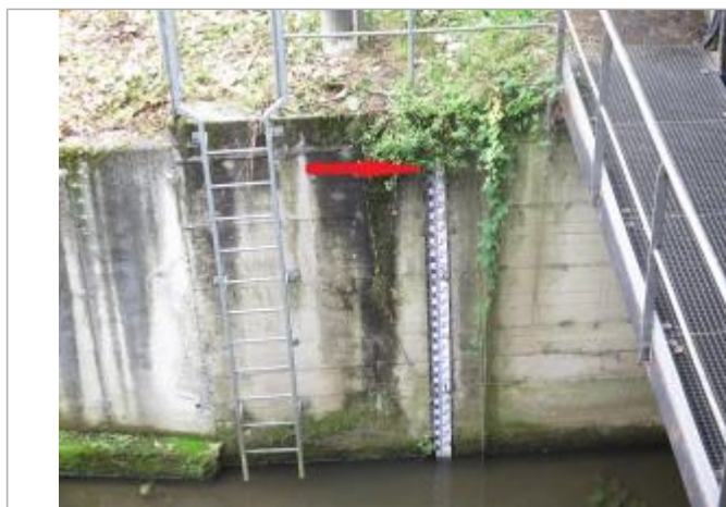
Echelle limnimétrique de la station de Vitré Bas Pont
