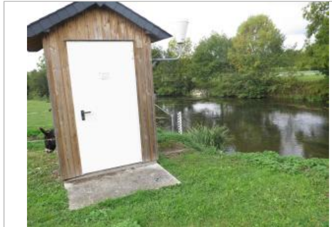
Vue générale de la station de Pont Briand à Cesson Sevigné
