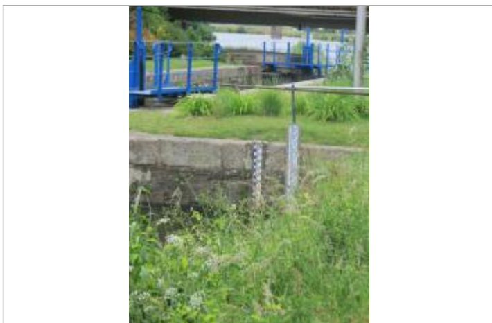
Echelle limnimétrique sur bajoyer amont de l'écluse de Guipry
