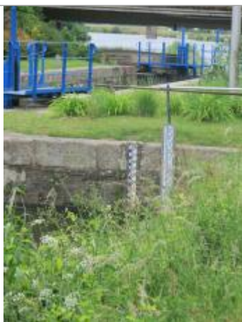
Echelle limnimétrique sur bajoyer amont de l'écluse de Guipry
