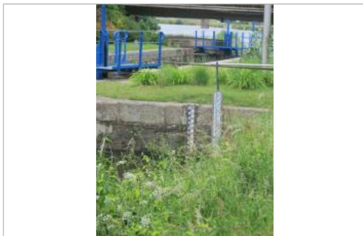
Echelle limnimétrique sur bajoyer amont de l'écluse de Guipry
