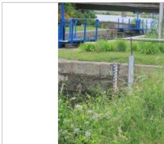
Echelle limnimétrique sur bajoyer amont de l'écluse de Guipry
