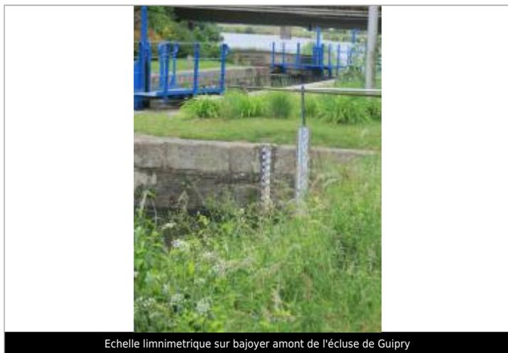
Echelle limnimétrique sur bajoyer amont de l'écluse de Guipry
