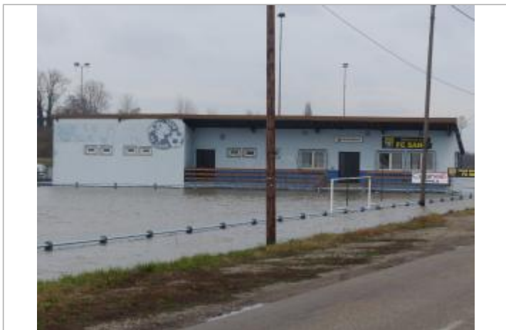
Repère nivellable au niveau des barrières du stade de foot, quelque centimètres en dessous du maximum
