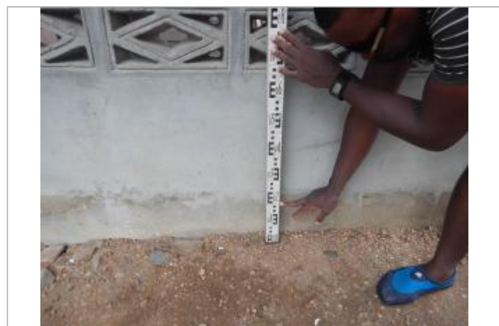
Vue du support de la mesure
