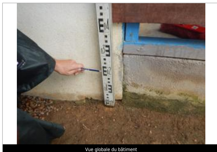
Vue globale du bâtiment
