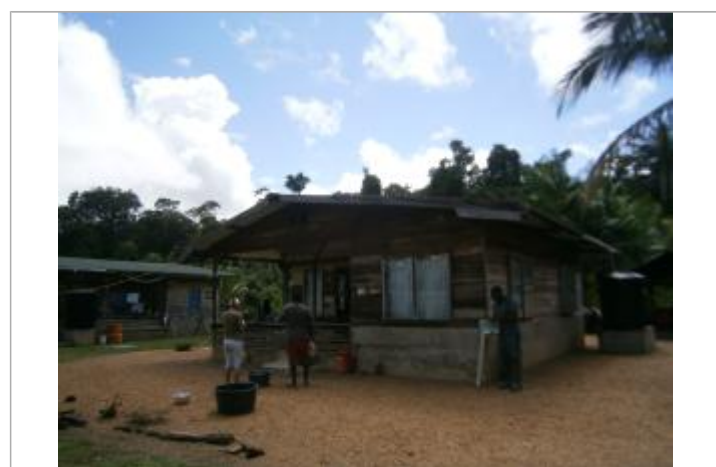
Vue du support de la mesure
