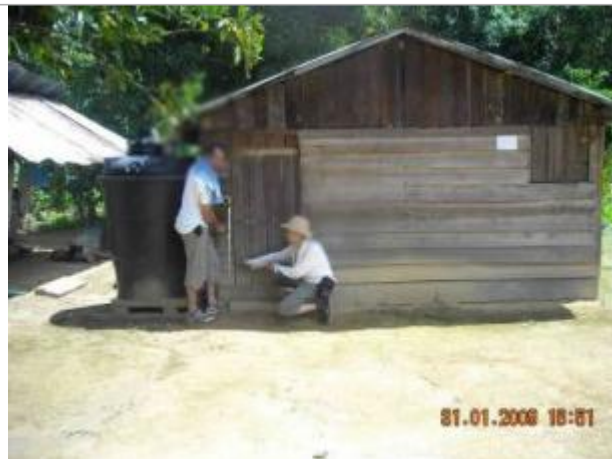
Vue globale du bâtiment
