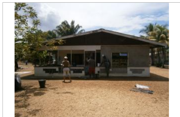
Vue du support de la mesure
