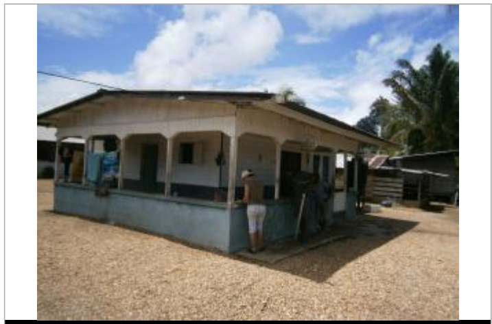
Vue du support de la mesure
