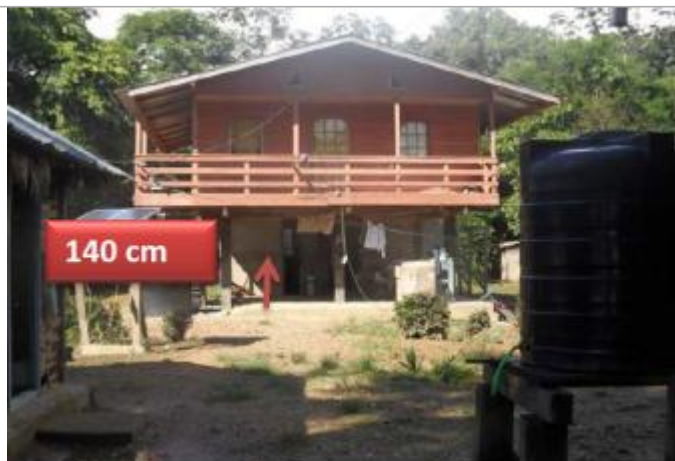
Vue globale du bâtiment
