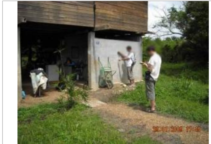
Vue globale du bâtiment
