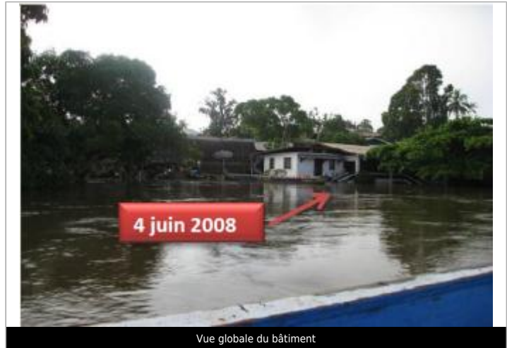
Vue globale du bâtiment
