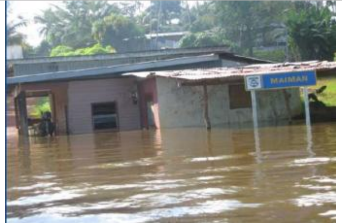
Vue globale du bâtiment
