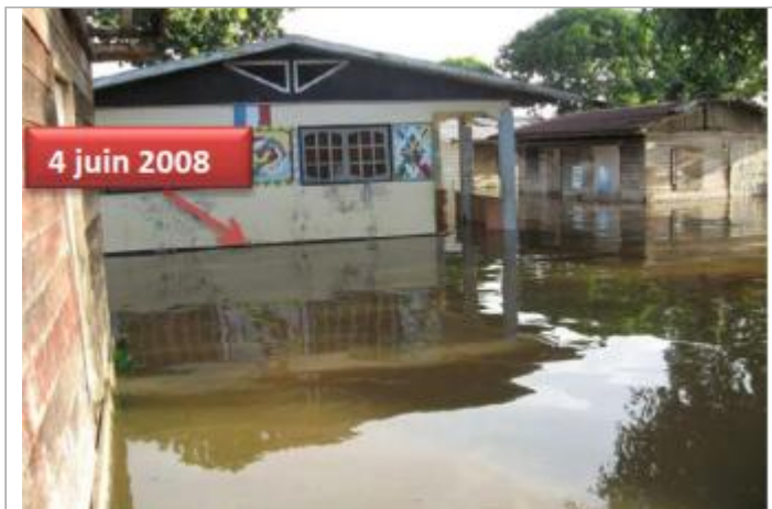
Vue globale du bâtiment
