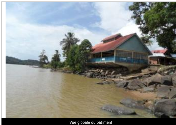
Vue globale du bâtiment
