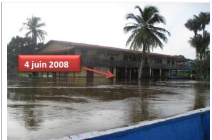
Vue globale du bâtiment
