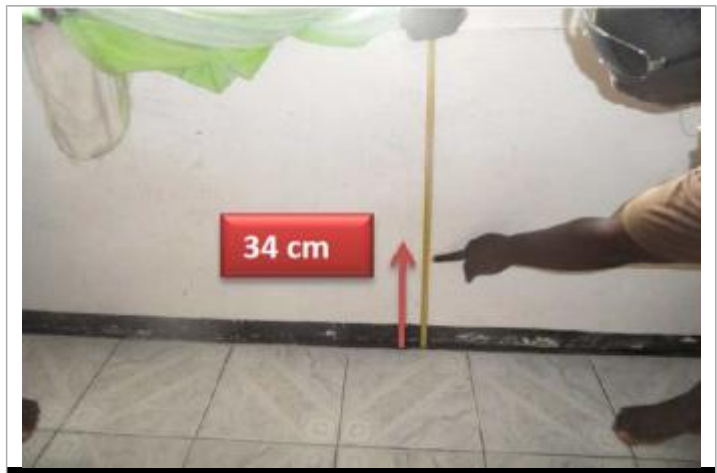
Vue du support et de la mesure du niveau des PHE
