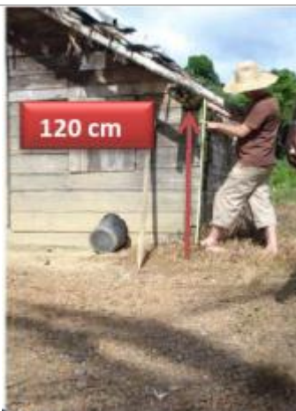
Vue du support et de la mesure du niveau des PHE
