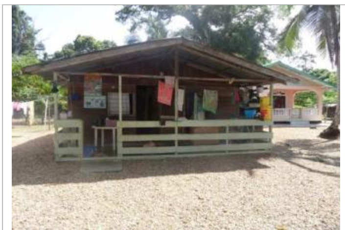
Vue globale du bâtiment
