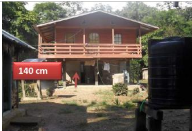
Vue globale du bâtiment
