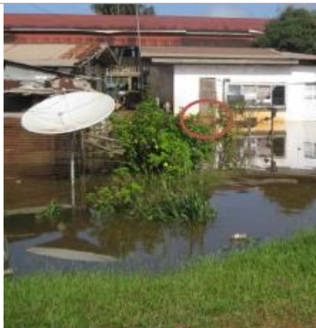
Vue globale du bâtiment
