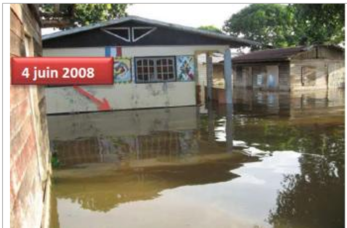
Vue globale du bâtiment
