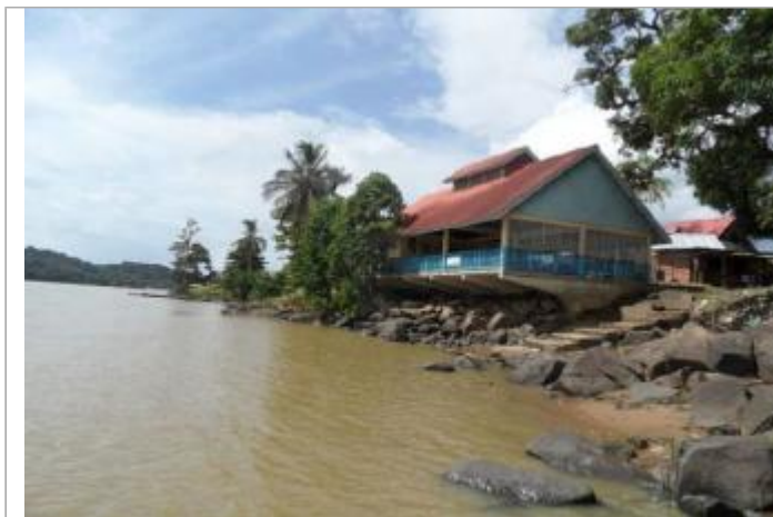
Vue globale du bâtiment
