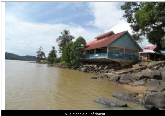
Vue globale du bâtiment
