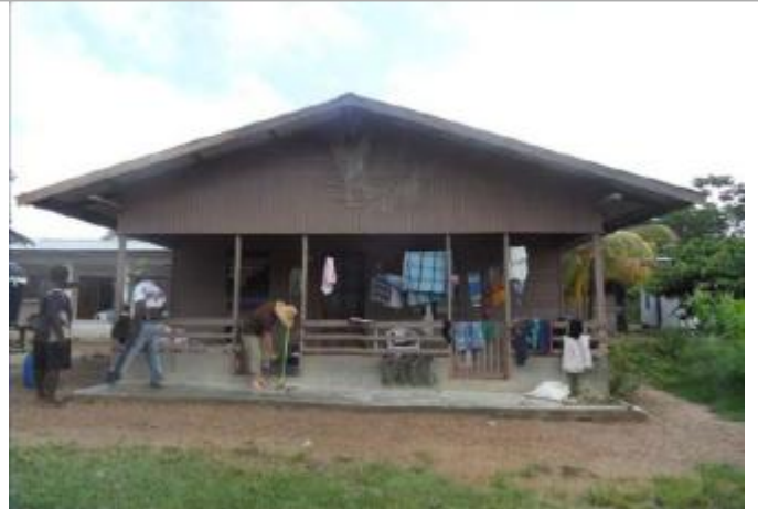
Vue globale du bâtiment
