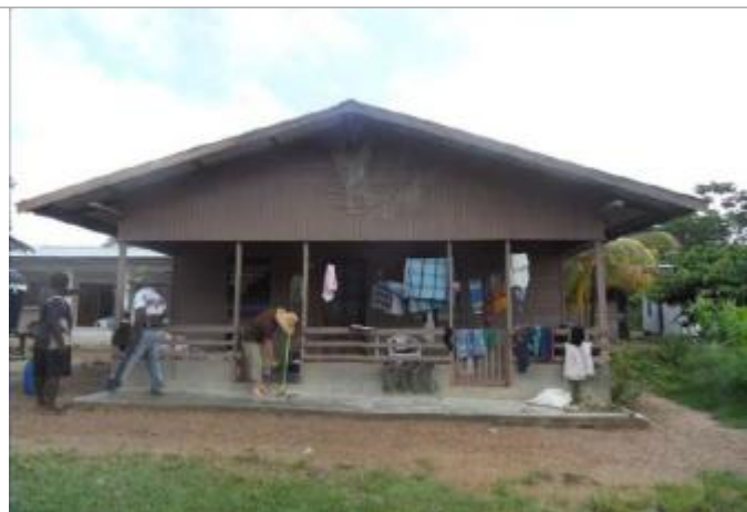
Vue globale du bâtiment
