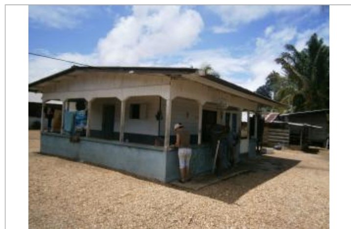
Vue du support de la mesure
