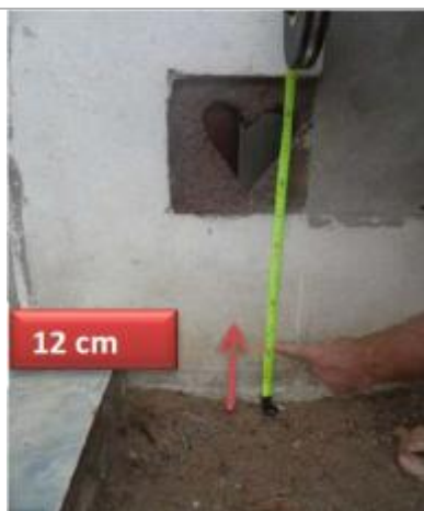
Vue du support et de la mesure du niveau des PHE
