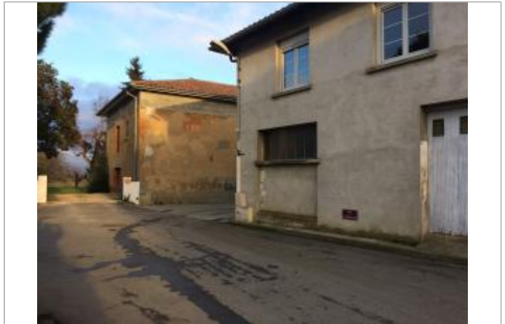
Vue du site
