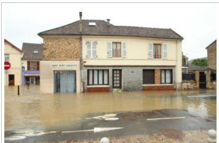
inondation par débordement 17 rue de la république
