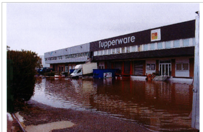
Inondation 2 avenue du Patis
