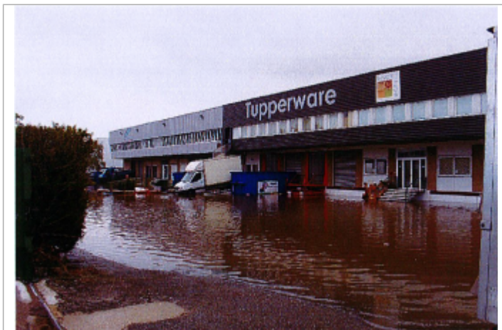
Inondation 2 avenue du Patis
