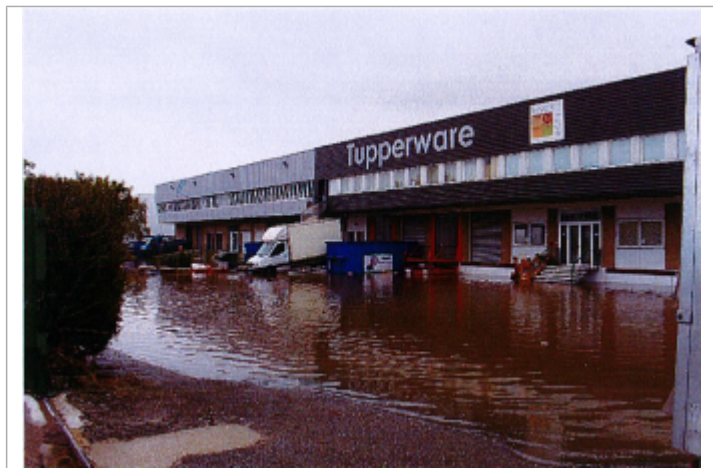
Inondation 2 avenue du Patis
