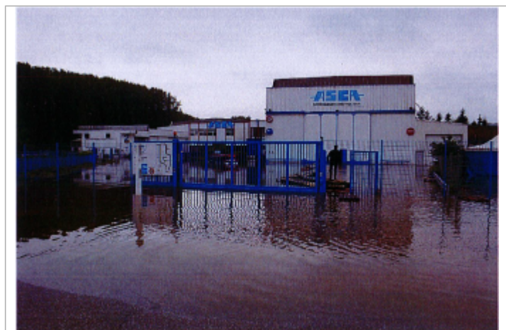
Inondation 1 route de Nezel
