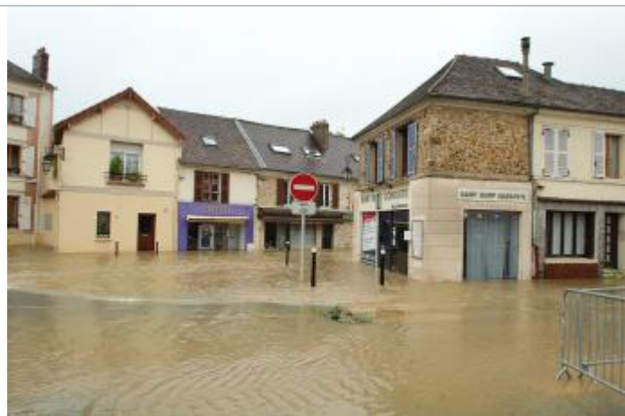
Laisse d'inondation sur les murs des bâtiments proche du 5 rue Chesneau
