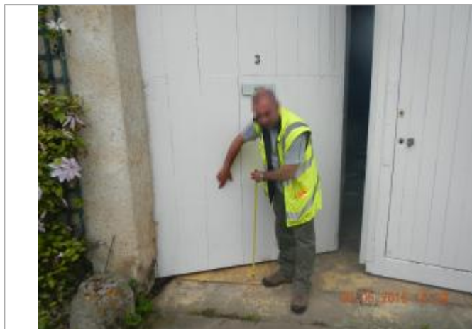
Trace horizontale laissée par la crue sur la porte du garage
