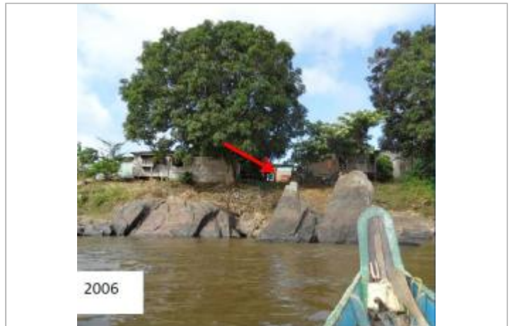
Vue globale du bâtiment
