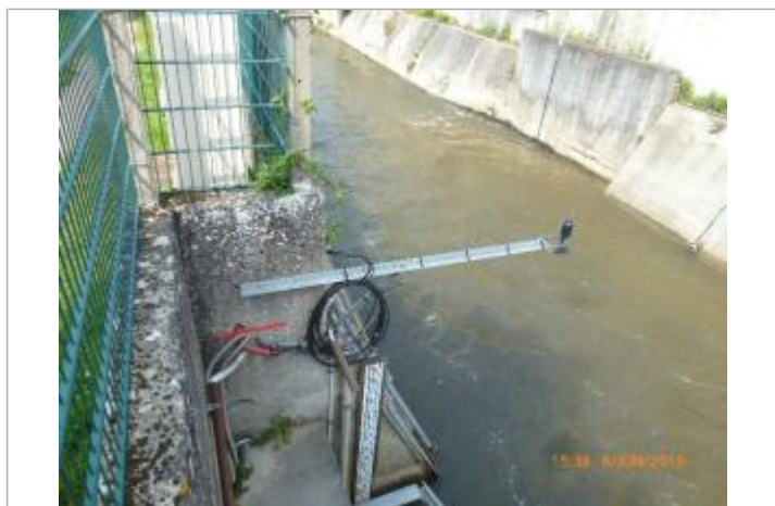
Niveau d'eau juste en dessous du trou de la gaine rouge
